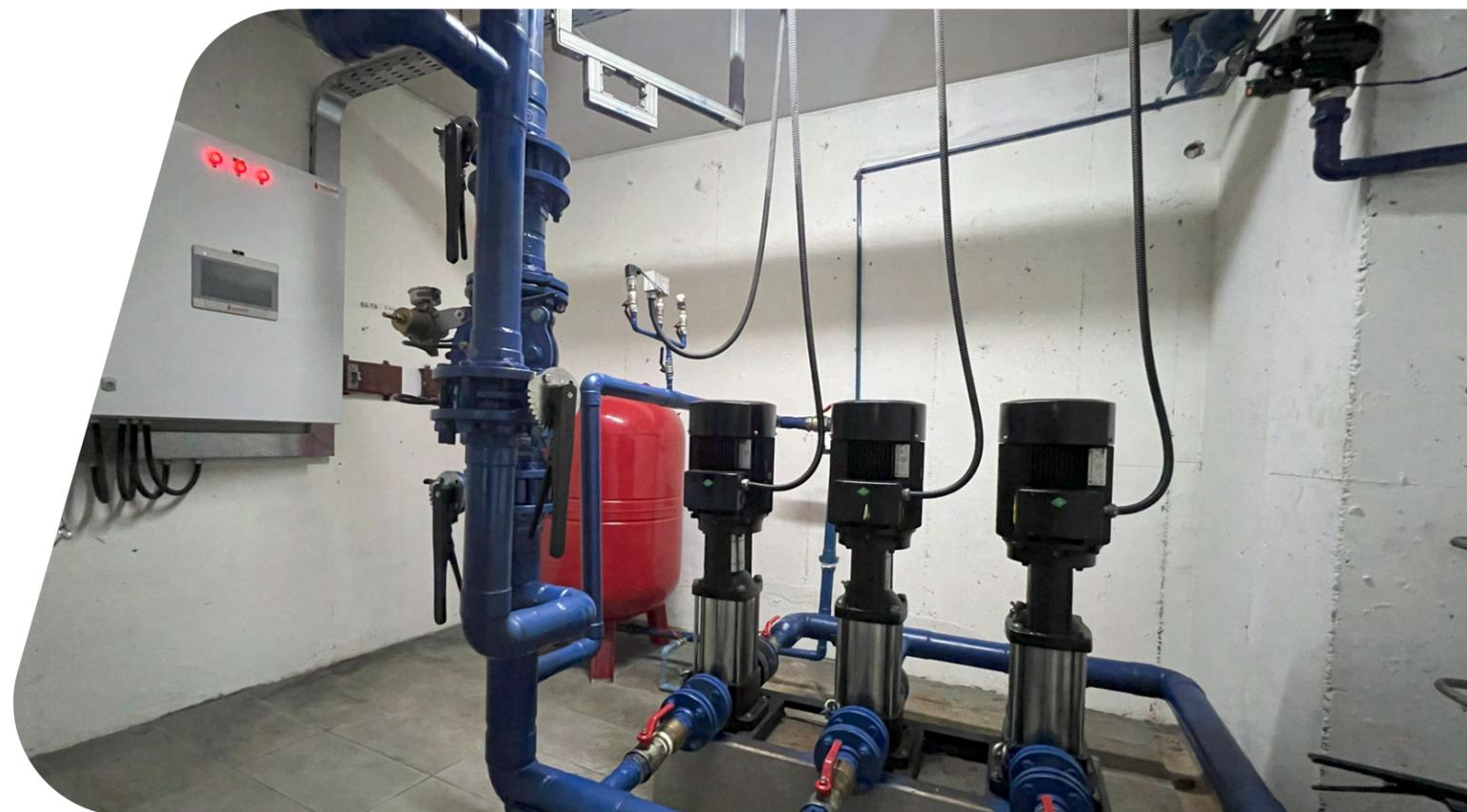
*En el proyecto de sala de bombas, nos centramos en la modernización para asegurar un flujo de agua constante y eficiente. Esto implica la actualización de equipos, la implementación de sistemas de monitoreo en tiempo real, y la adopción de tecnologías que optimizan la presión y el consumo energético. Nuestro enfoque es garantizar la fiabilidad del sistema, reducir costos operativos y minimizar el impacto ambiental mediante prácticas más eficientes.*
